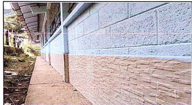
Foto 4: Se observa la colocacion de las fachaletas alrededor de las aulas del establecimiento.
