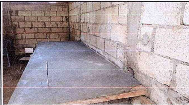
Foto 3: Se observa la construccion del desayunador.
