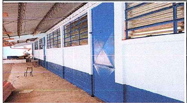
Foto 2: Se observa las paredes de las aulas tanto como adentro y afuera ya pintadas
