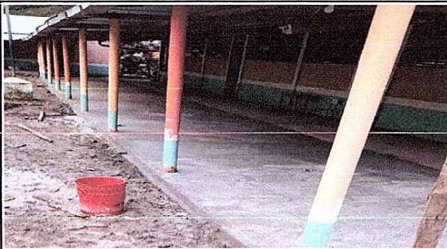
Foto 1: Se observa la torta de concreto en el corredor de las aulas.
