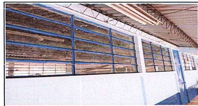
Foto 6: Se observa la colocacion de las ventanas del establecimiento.
